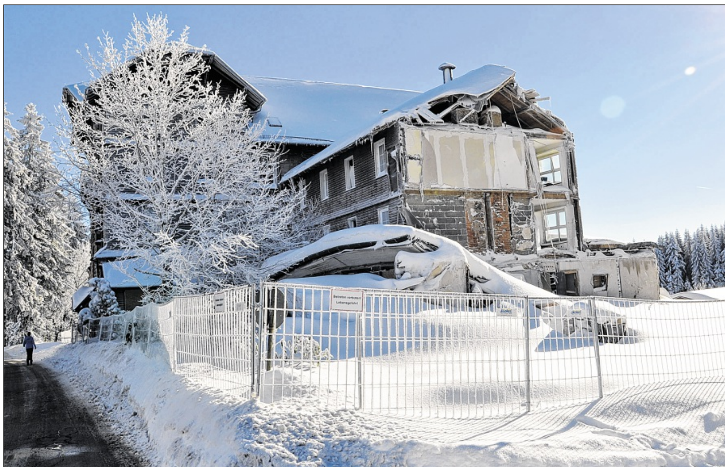
KEIN SCHÖNER ANBLICK: Vom ehemaligen Kurhaus Hundseck stehen seit den Abrissarbeiten im Herbst nur noch Teile. Der Bauschutt lagert nach wie vor an der Schwarzwaldhochstraße. Foto: Margull
